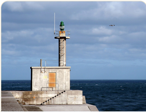
Faro al final del dique Oeste, custodiando la bocana del Nalón.
